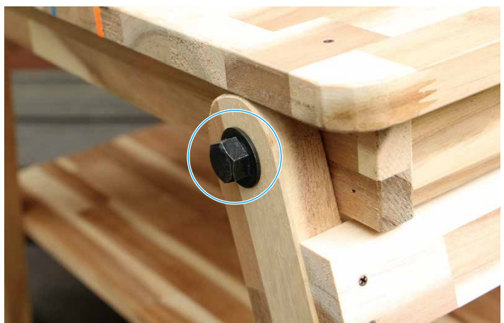
【ボルトのゆるみは定期定期に確認し、ゆるみがある場合は締めなおしてください】
